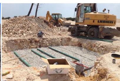
Travaux de création du champ d'épandage du système d'assainissement autonome
