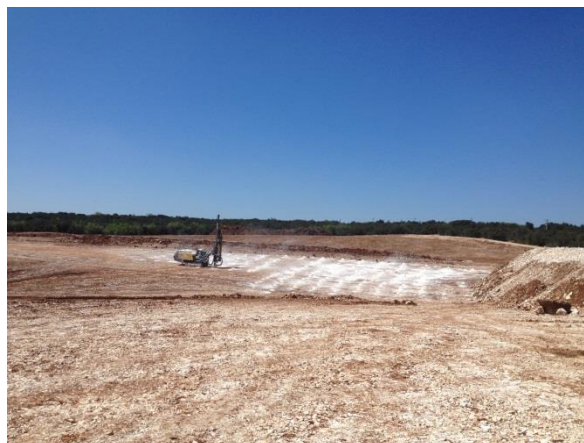
Photographie de la foreuse en avril 2015
