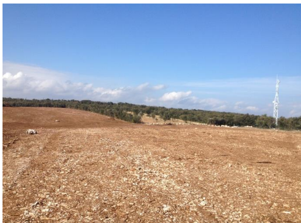
Photographie des travaux de défrichage réalisés sur le site en février 2015
