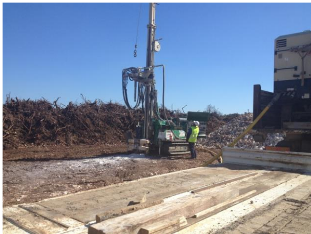
Travaux de création du forage en avril 2015 réalisés par une société spécialisée
