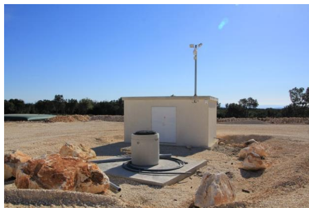
Forage à l'issue des travaux
