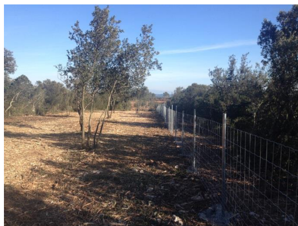
Photographie des travaux de clôture en janvier 2015
