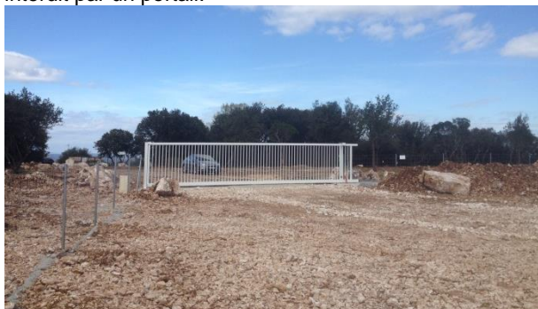
Photographie du portail d'entrée installé en avril 2015
