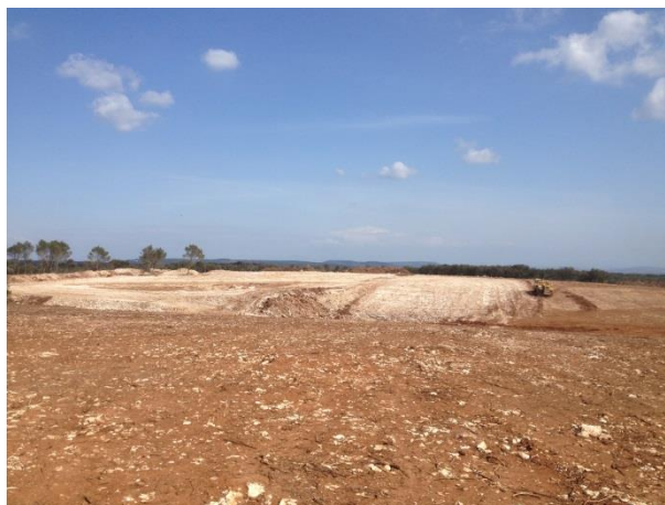
Photographie des travaux de décapage réalisés sur le site en mars 2015
