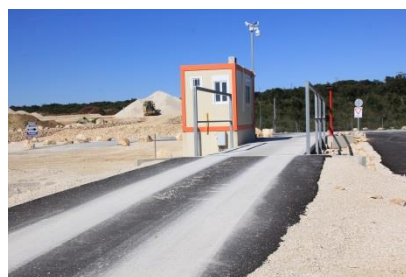
Pont-basculé et local bascule
