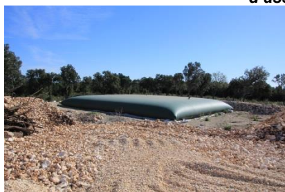
Réservoir souple d'eau de 120 m 3 réservée à la lutte contre l'incendie
