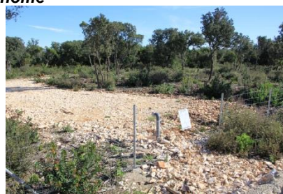
Raccord pompier de cette réserve, placé à l'extérieur de la carrière
